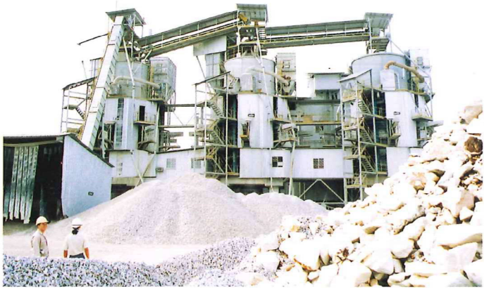
マレーシア ロックケミカル社殿 Malaysia (Rock Chemical Industries Berhad)
