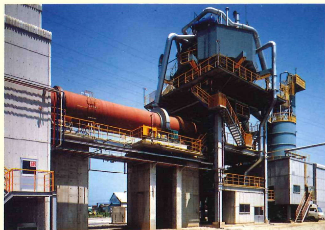
マグネシウム製造のためのマグネサイトの高品質焼成 70 tons/day、1988年建設 High-quality calcination of magnesite for magnesium production, 70 tons of product per day, constructed in 1988
