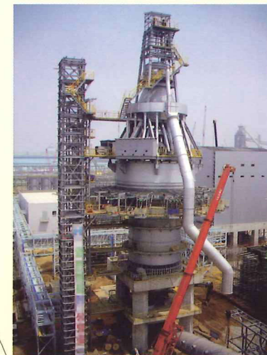
原石ビン据付 INSTALLATION OF UPPER BIN
