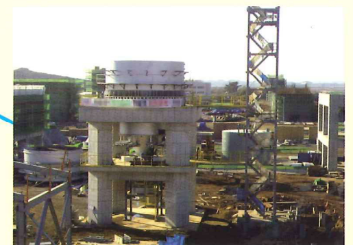
第一段鉄皮据付 INSTALLATION, SHELL OF FIRST LEVEL
